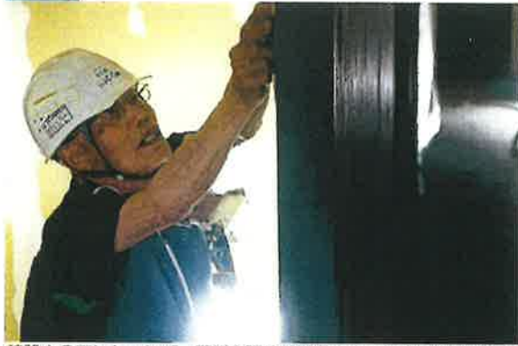
建設中のマンションで、壁紙を張る鷺野晃さん＝名古屋市千種区で
